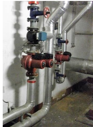
Figura 8.9– Particolare delle pompe di circolazione
