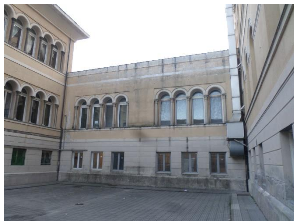
Figura 4.2 - Particolari della facciata
