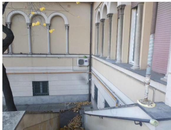
Figura 4.1 - Particolare dell'involucro murario al piano terra
