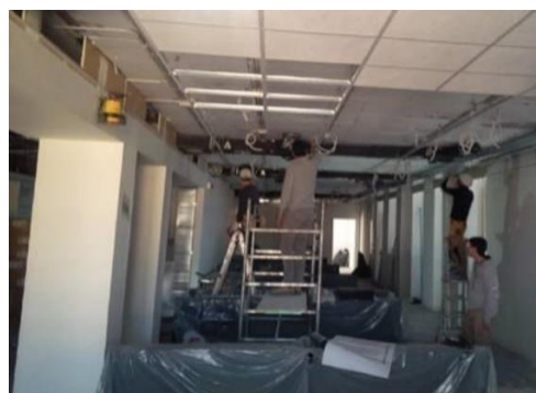
Figura 8.4- Particolare installazione controsoffitti
