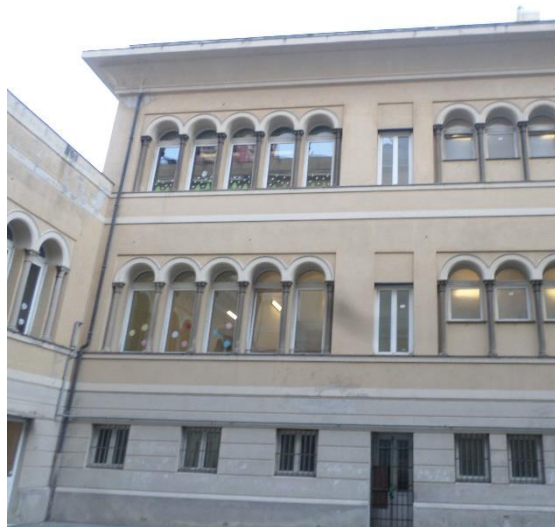
Figura 1.1 - Vista della facciata interna esposta a Nord-Ovest
